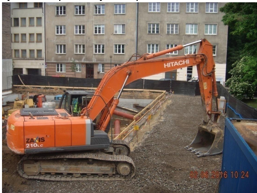
Rysunek 2. Poprawnie wykonana platforma robocza
