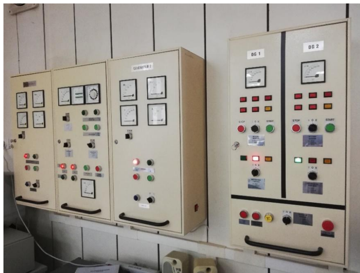
Rys.4. Symulator elektrowni okrętowej, źródło: opracowanie własne na podstawie [6]
