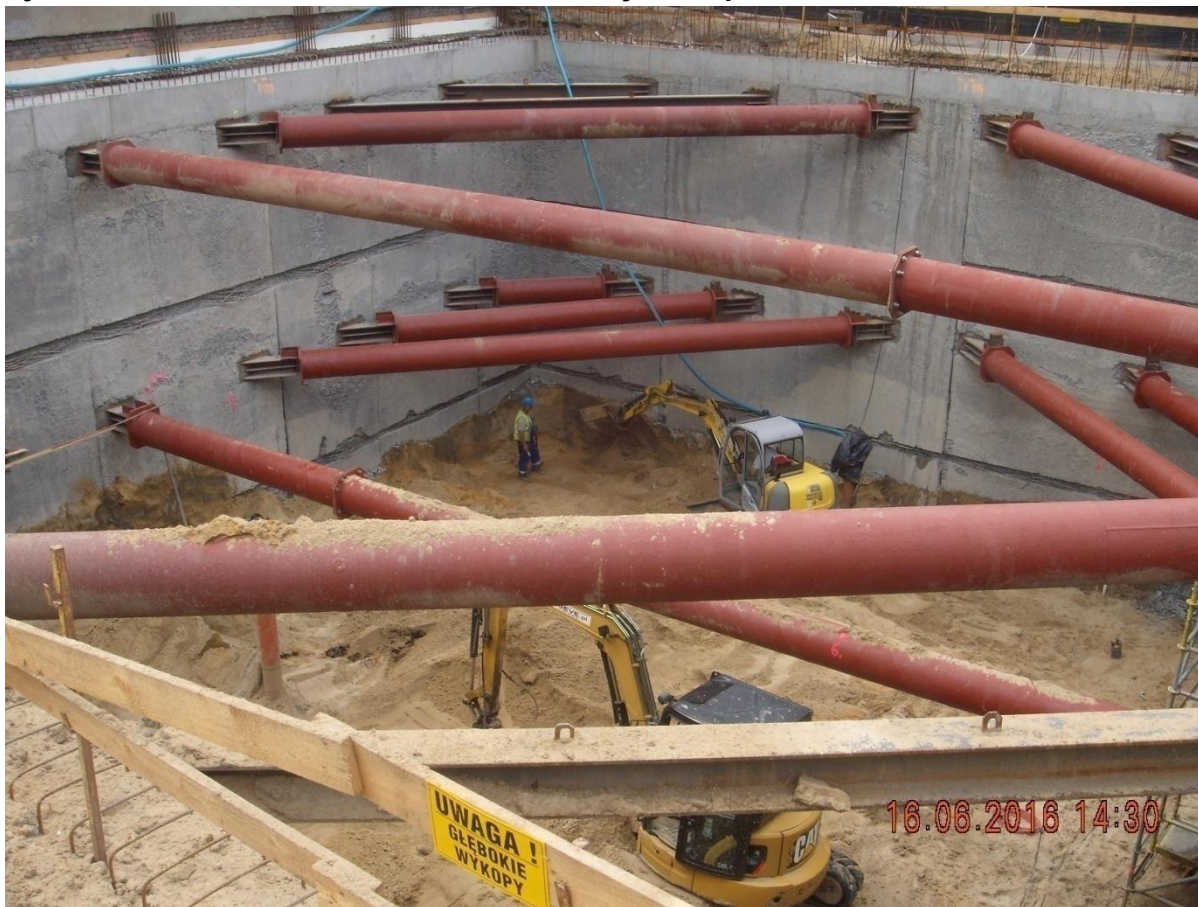
Rysunek 6. Ścianka szczelinowa z dodatkowymi rozporami
