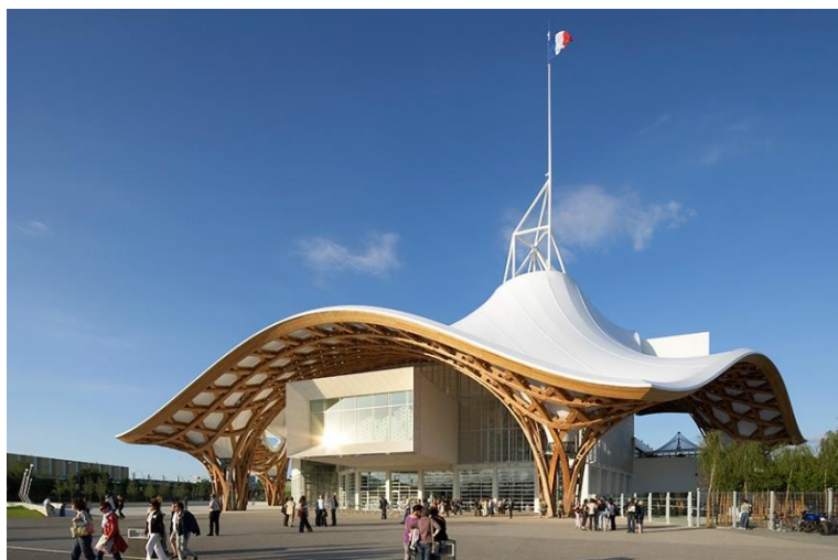
Ryc. 4. Centrum Pompidou-Metz, Francja
