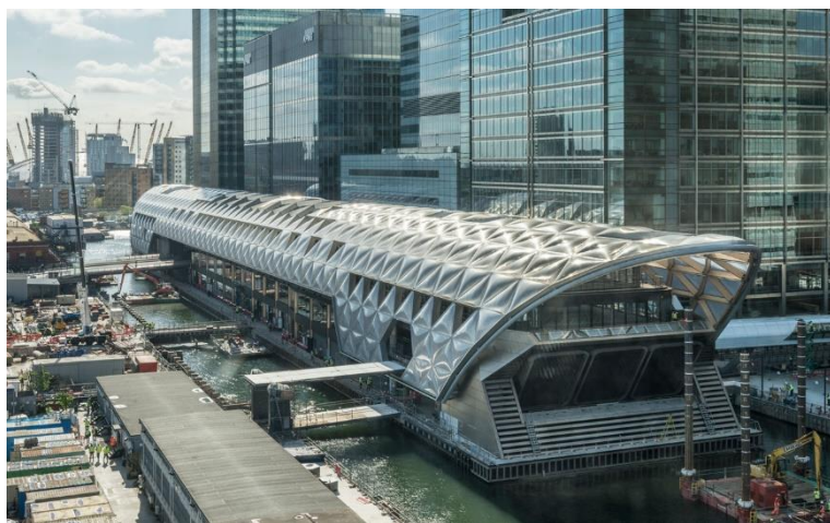
Ryc. 3. Stacja Canary Wharf w Londynie
